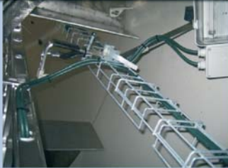
Montage des chemins de câble et de la petite câblerie
