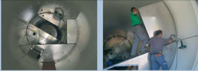
Montage des échelles reliant le sol au dessus de l'éolienne.
