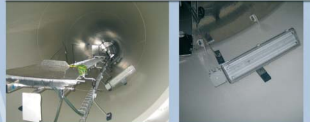
Installations des luminaires et leurs alimentations
