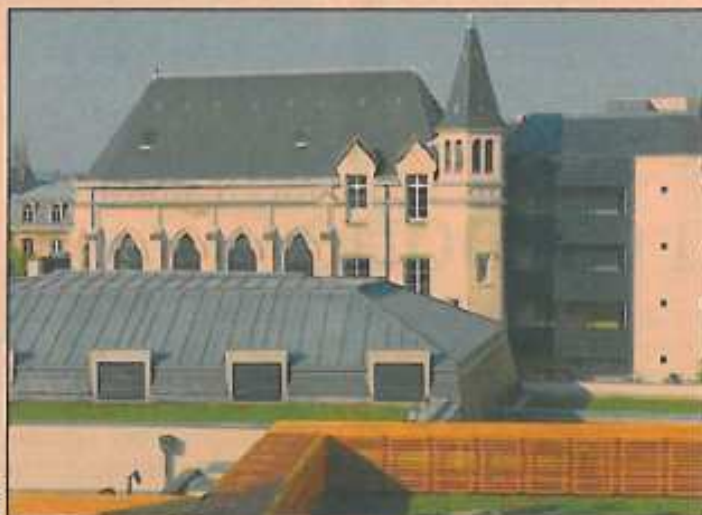
La toiture végétalisée renforce naturellement l'isolation du toit.
