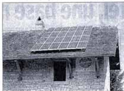
Photovoltaïque : une alternative dans les cas d'habitat groupés des réseaux
