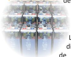
Le parc de batteries est dimensionné en fonction de l'autonomie souhaitée de la production pour des besoins déterminés. L'augmentation de la surface du champ solaire n'a pas d'incidence sur la capacité de stockage du parc mais réduit en revanche sa durée de chargement.
